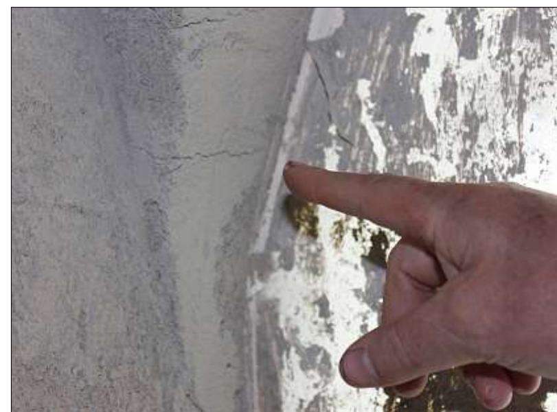
Rudolf Rechl kauft für seine Bauwerke nichts von der Stange. Die Eichen-Kastenfenster mit Lederdichtungen hat er selbst entwickelt. Dem Putz lässt er viel Zeit zum Trocknen. Die kleinen Risse werden später noch einmal mit einer zweiten Lage bedeckt.
