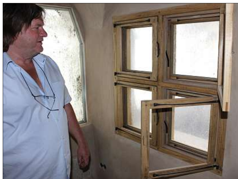
Rudolf Rechl kauft für seine Bauwerke nichts von der Stange. Die Eichen-Kastenfenster mit Lederdichtungen hat er selbst entwickelt. Dem Putz lässt er viel Zeit zum Trocknen. Die kleinen Risse werden später noch einmal mit einer zweiten Lage bedeckt.
